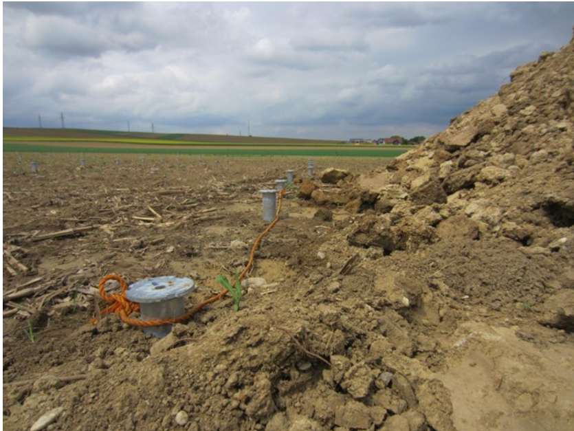
Abbildung 3: Ankerpfiler als Grundgerüste für die aufzustellenden Kollektorflächen
