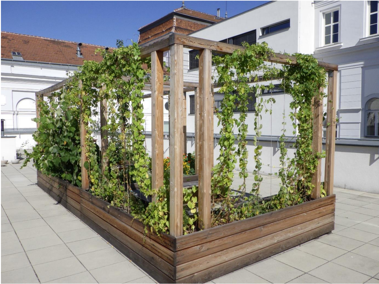
Abbildung 8: Pergola auf der Dachterrasse BRG16
