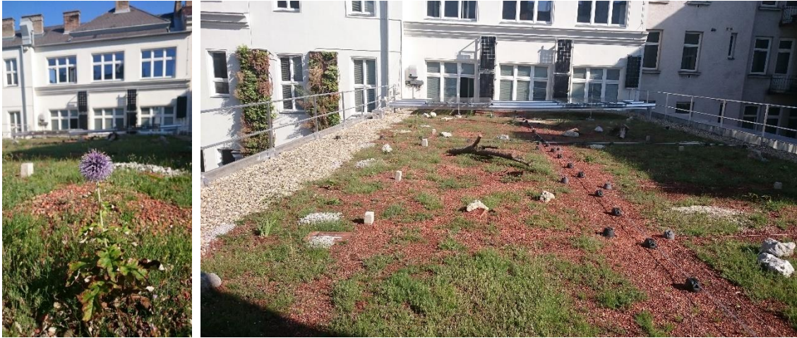
Abbildung 4: Dachbegrünung GRG 7 Kandlgasse, 1070 Wien
