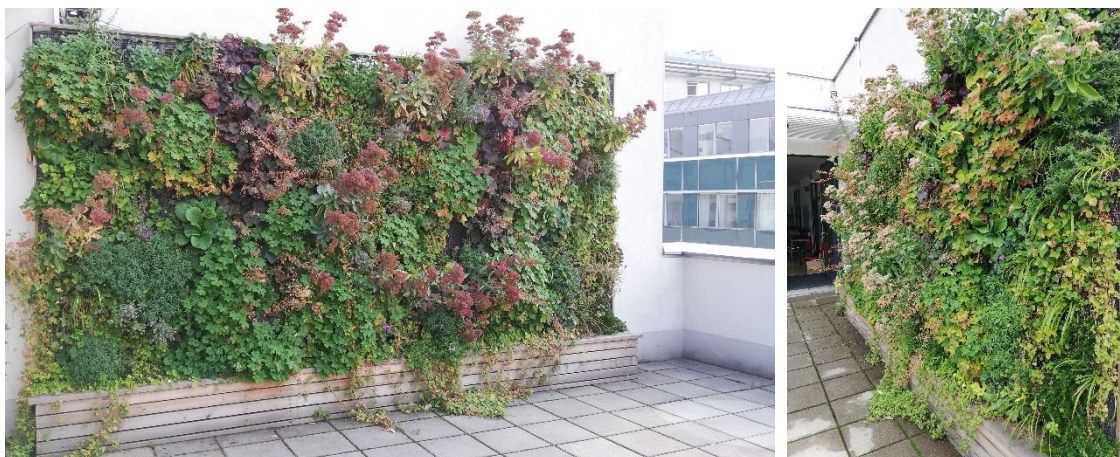
Abbildung 2: Fassadenbegrünung mittels Kassettensystem auf der Dachterrasse des BRG 15 Diefenbachgasse
