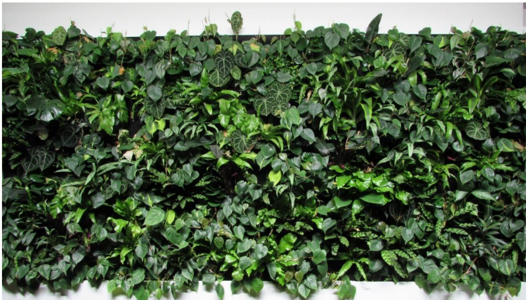
Abbildung 14: Vliessystem im Innenraum, BRG 15 – Diefenbach Gymnasium
