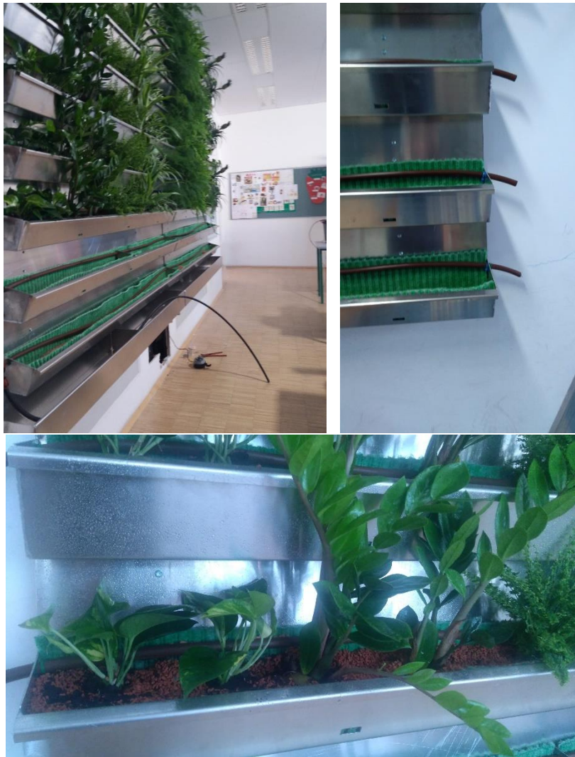
Abbildung 21: Installation des Bewässerungssystems im Trogsystem
