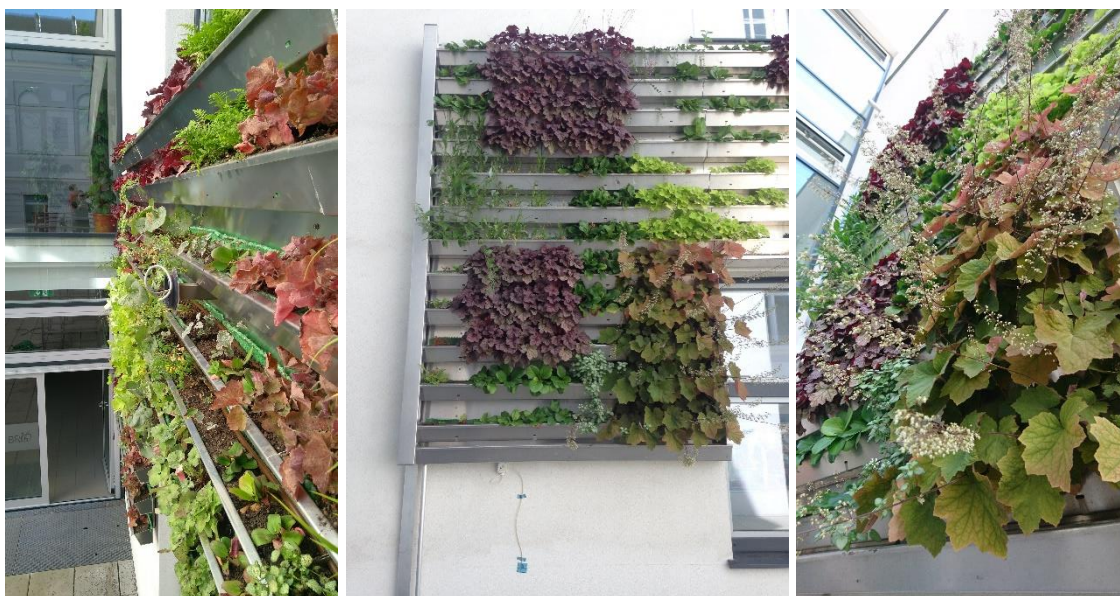
Abbildung 3: Hofseitige Fassadenbegrünung mittels Trogsystem im BRG 16 Schuhmeierplatz
