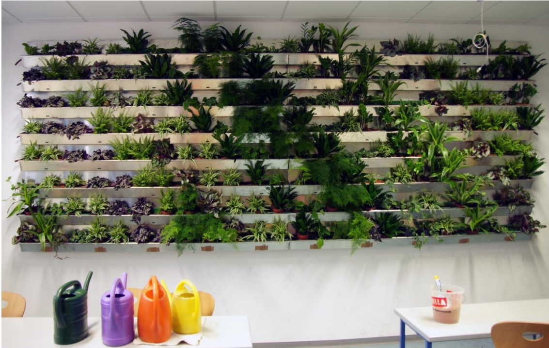
Abbildung 9: Trogsystem im Innenraum, schräg versetzte Pflanzenanordnung
