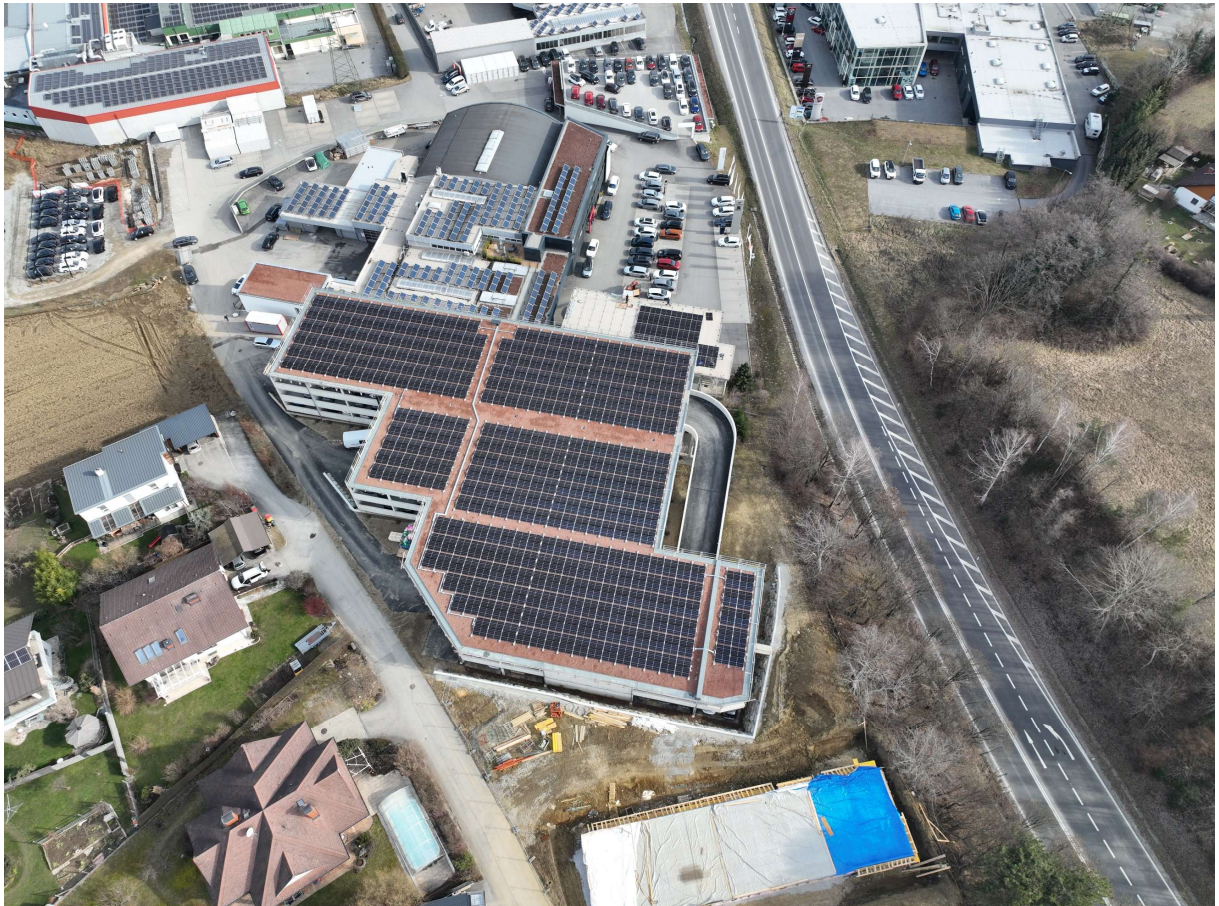
Abbildung 2: PV-Anlage Gesamtsicht Firmengelände
