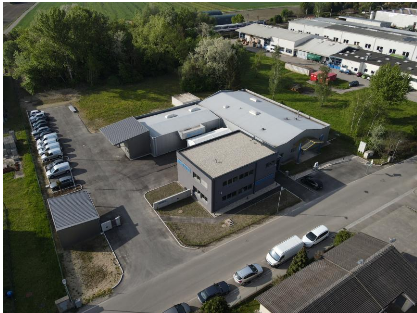
Vor der Errichtung
