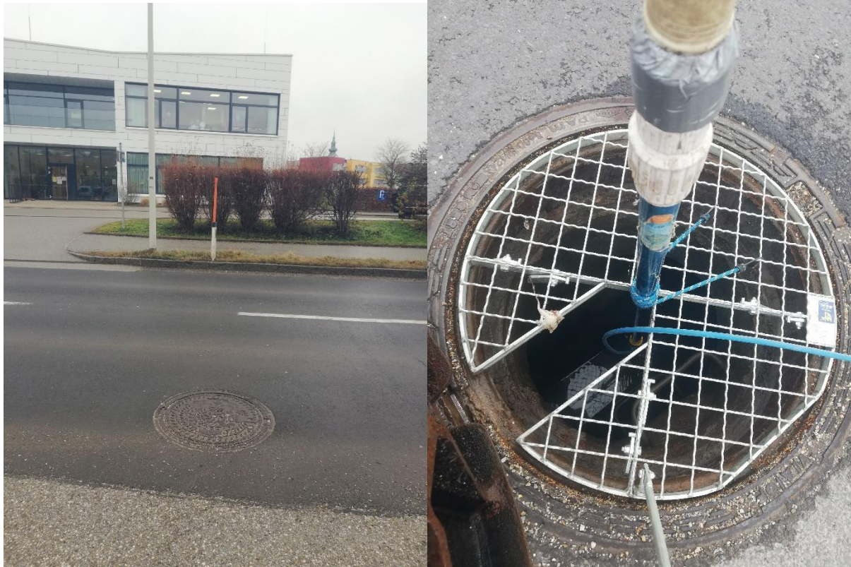
Abb.15/16: Messung bei Messpunkt 6 in der Nähe des Kindergartens Leonding
