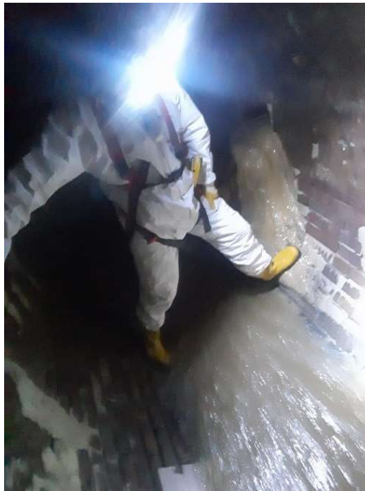
Abbildung 8: Mitarbeiter mit Schutzausrüstung im Kanal bei Montage des Sensors
