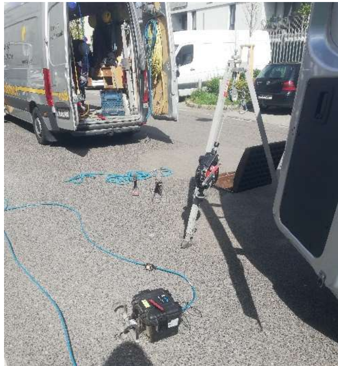
Abbildung 12: Dreibein, Messumformer und Busse beim Einbauen des Sensors
