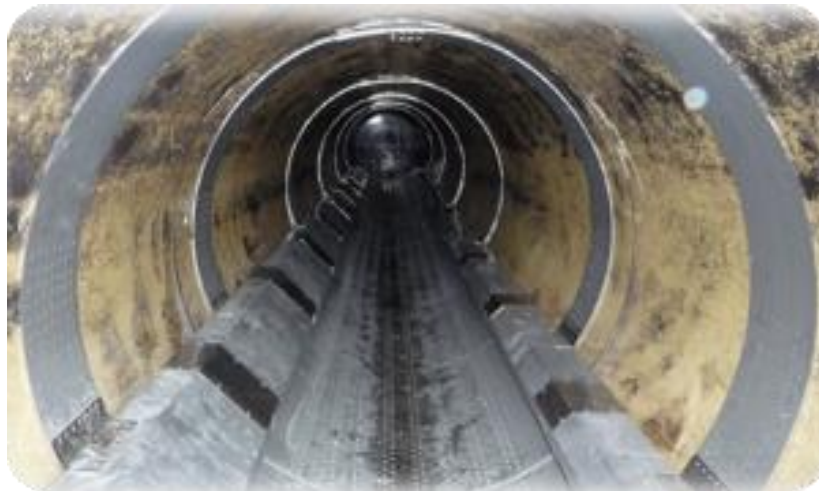
Abb.28: Beispiel für verlegte Wärmetauscher im Kanal, begebar, keine Unterspülungen/Verstopfungen
