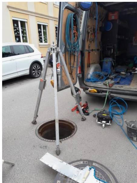
Abb. 7: Absicherung für den Einbau der Messonden, an MP1
