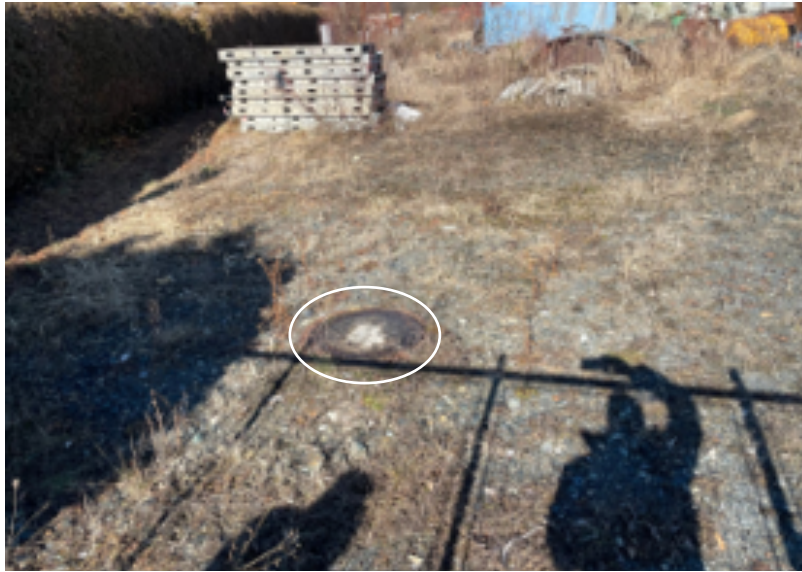
Abb. 7: Blick auf Schachtdeckel am Betriebsgelände nahe der Gemeinde
