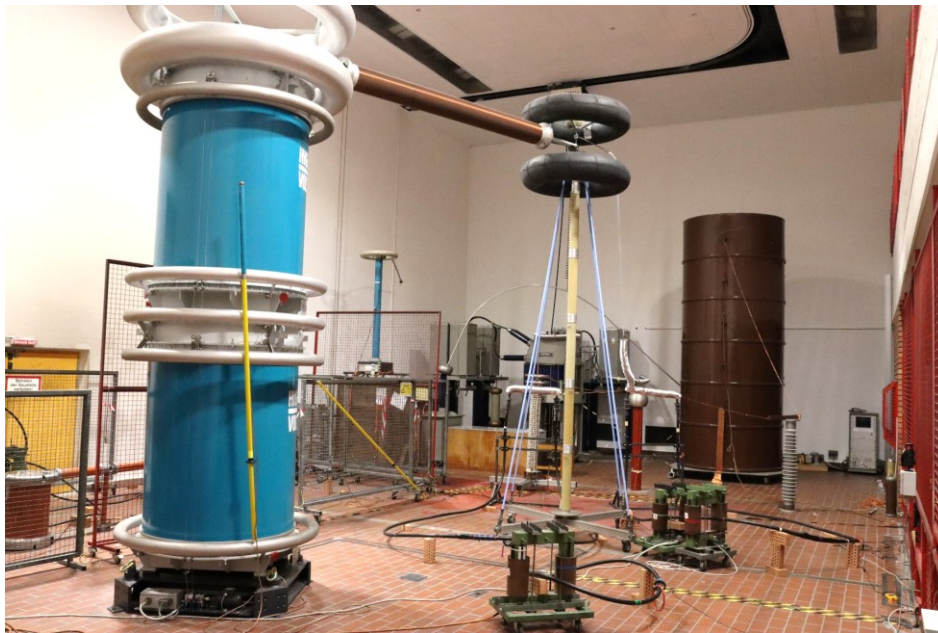
Abbildung 32 - Prüfung eines Mittelspannungs-AC-Kabelsystems für den Einsatz in einem MVDC-System
