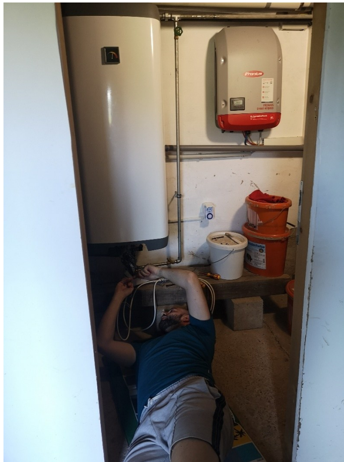
Abbildung 25: Nachrüstung des greencharge Moduls (Quelle: energiedigital)
