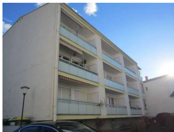
Abb. 22: Außenansicht Wienerstraße 11 von Nordwesten
