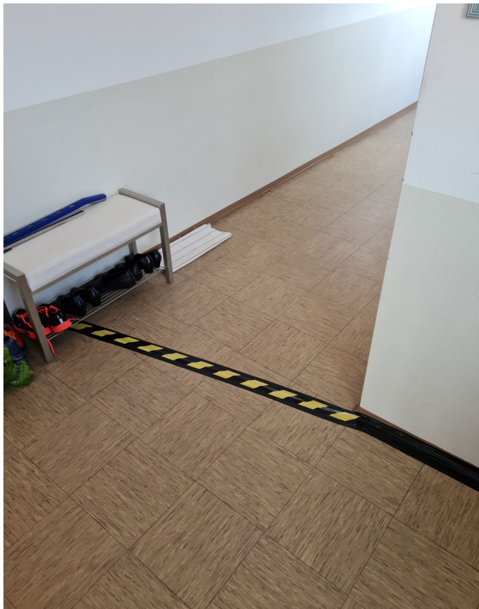
Abb. 24: Kabelverlegung am Boden eines Ganges (Wienerstraße 11a)
