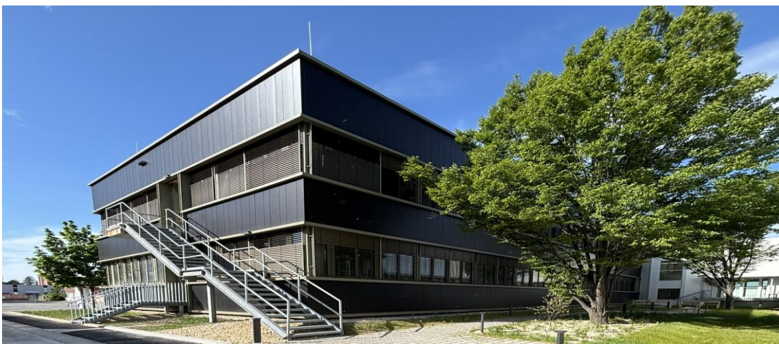
Abb.10: Innenhof nach Fassadensanierung
