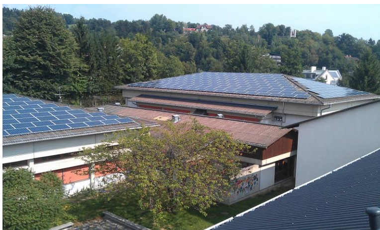
Abbildung 3: Teilanlage auf dem Dach der NMS Friedberg (©Biowärme Friedberg GmbH)
