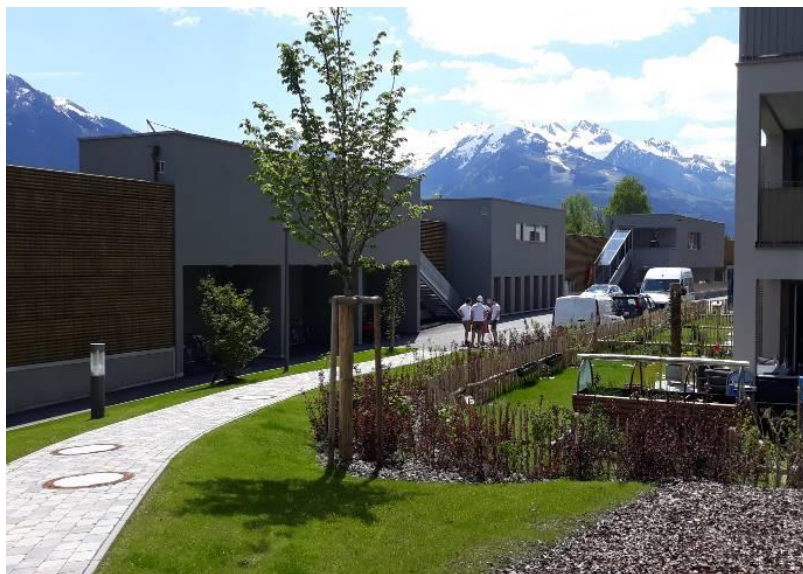
Abbildung 25: Impression der Lärmschutzwand I (SIR, 2020)
