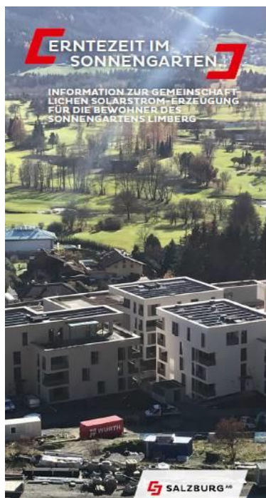
Abbildung 36: Impressionen der Photovoltaik-Anlage II (Salzburg AG, 201)
