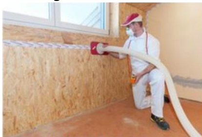
Beim Dachausbau wird Zellulose in Hohlräume eingeblasen
