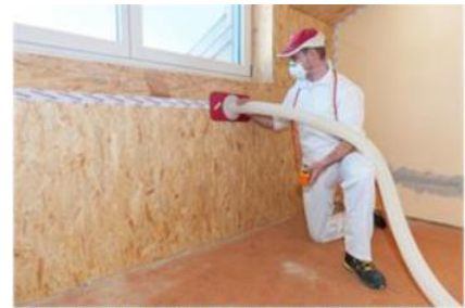
Beim Dachausbau wird Zellulose in Hohlräume eingeblasen
