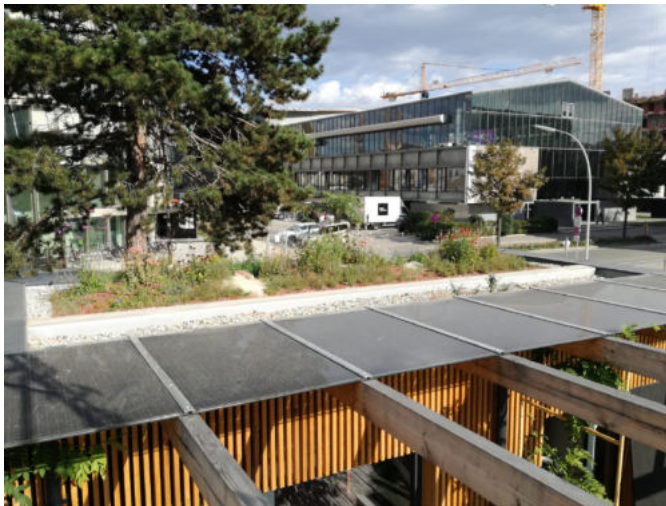
Abb. 5: Als Vordach am green.LAB Graz ist eine Photovoltaik angebracht, die gleichzeitig als Schattenspender dient. Das Dach ist als Hälfte als Biodiversitäts-Dach und als andere Hälfte als Kiesdach ausgeführt. Zur Besichtigung des Daches wurde ein Treppenturm
