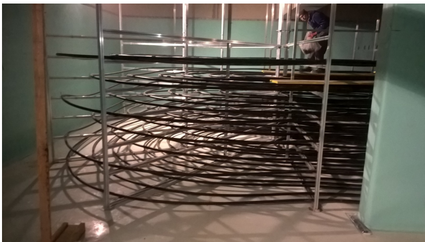
Einbau des Wärmetauscher-Systems beim Eisspeicher (Stahlbeton) mit einem Volumen von rd. 1.000.000 l
