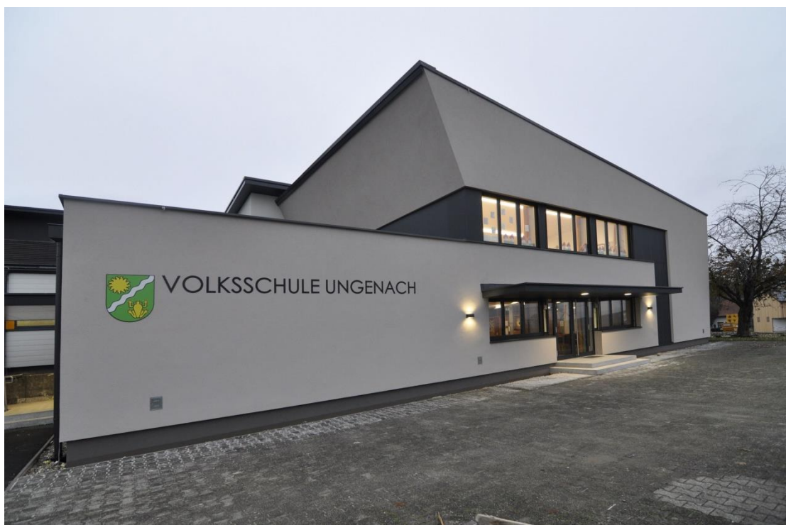
Ansicht süd-west nach der Sanierung
