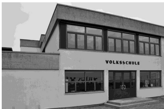
Ansicht süd-west vor der Sanierung
