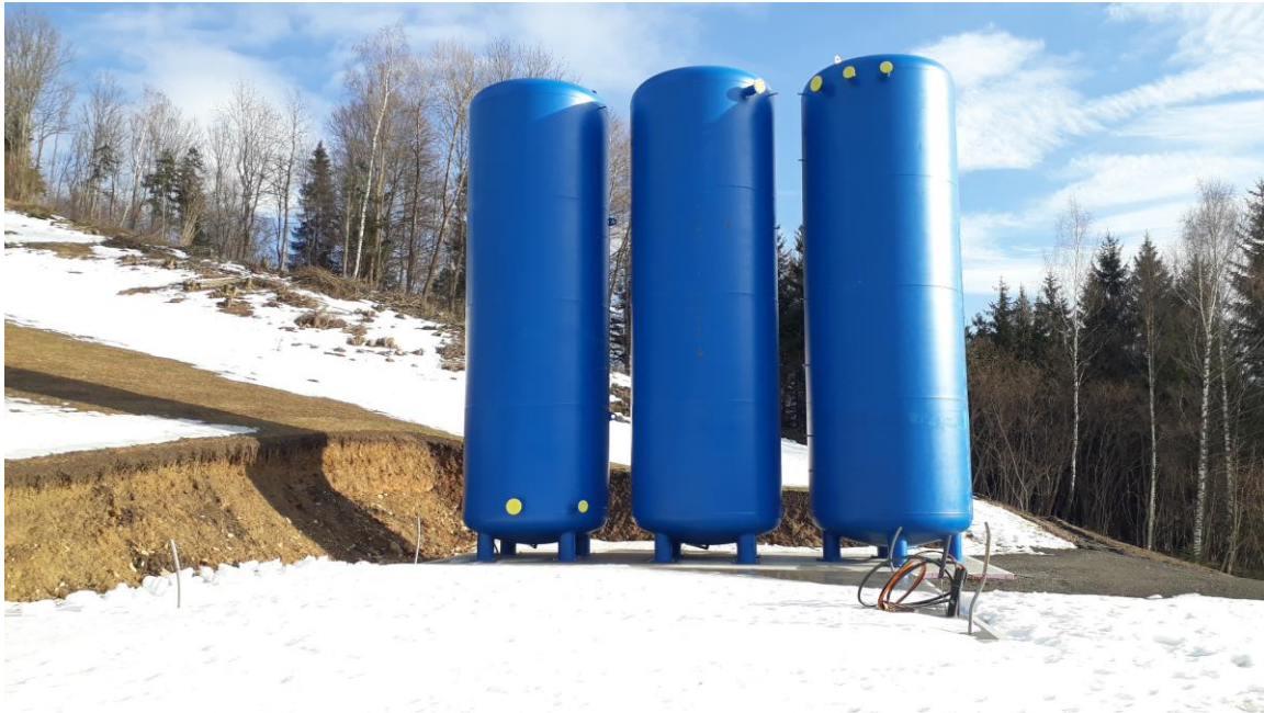
Abbildung 2: die ersten Schritte – die Pufferspeicher standen noch vor dem Technikgebäude und dem Kollektorfeld
