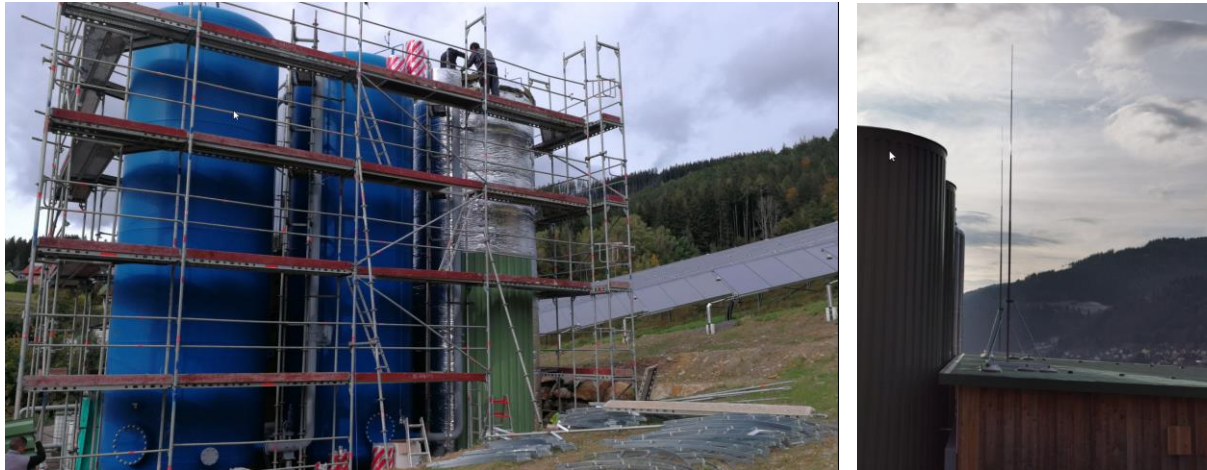
Abbildung 8: Die Pufferspeicher mit je 60m 3 werden vollständig isoliert und die gesamte Anlage mit Blitzschutz – Fangvorrichtungen versehen.
