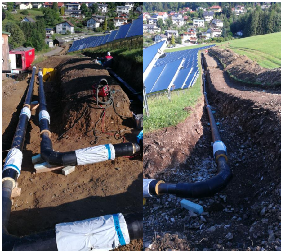
Abbildung 5: Verlegung der Solarfeld-Verrohrung
