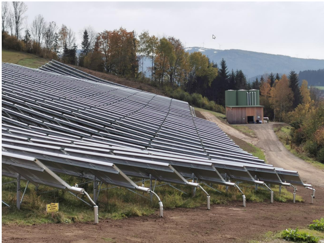
Abbildung 8: Die Pufferspeicher mit je 60m 3 werden vollständig isoliert und die gesamte Anlage mit Blitzschutz – Fangvorrichtungen versehen.
