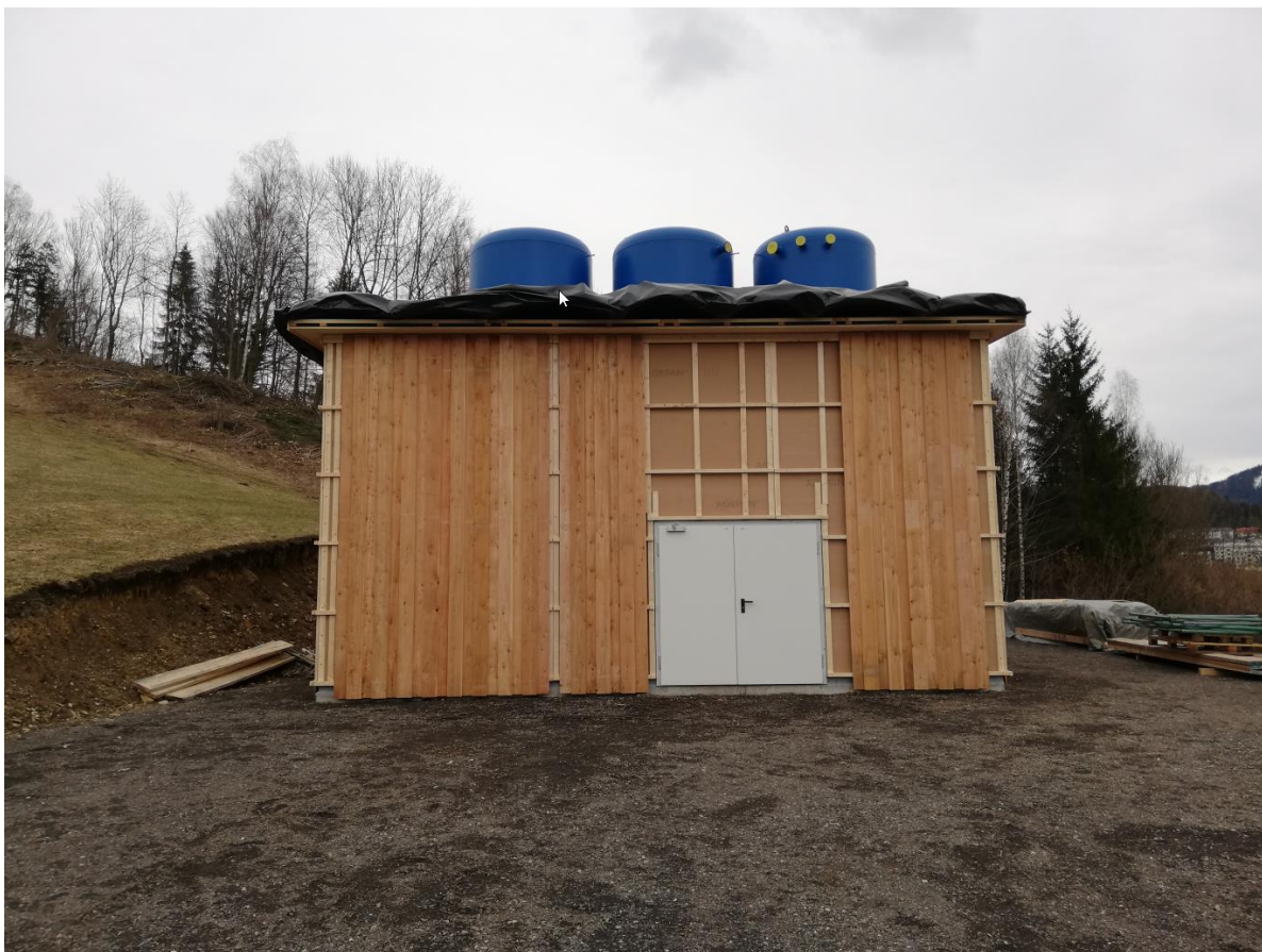
Abbildung 3: Errichtung der Technikzentrale in Holzriegelbauweise
