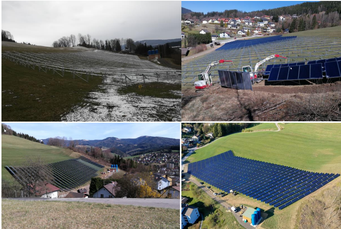
Abbildung 3: Bauphasen von der Errichtung des Kollektorfeldes
