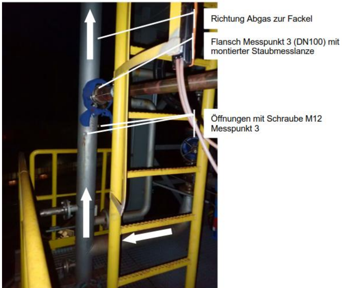
Abbildung 10 - Aufbau der Staubmessung im Reaktorabgas
