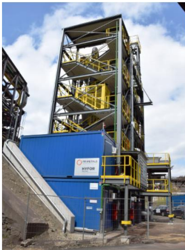
Abbildung 4 – Gesamtansicht der Anlage – Bild 2
