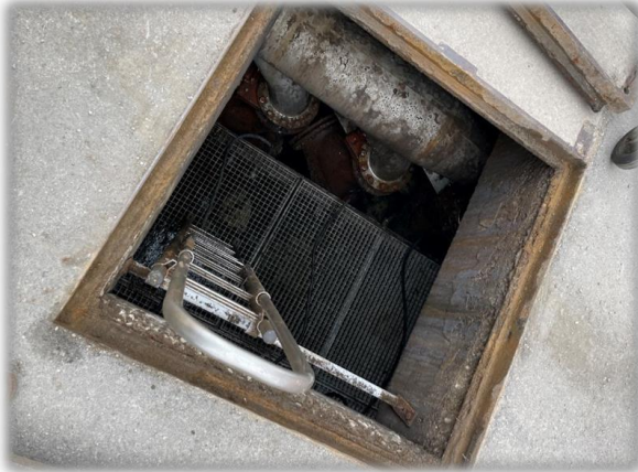
Abbildung 5: Besichtigung zentrale Pumpstation Seefeld (Münchnerstraße)
