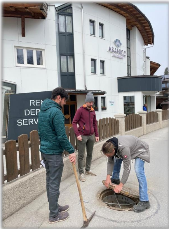
Abbildung 6: Gemeinsame Festlegung Messstellen am 30.03.2022 (Messpunkt 1 – Hotel Abanico)
