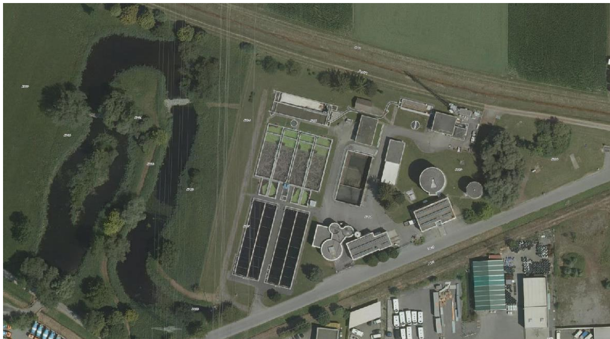
Abbildung 1 - Luftbild ARA Vorderland (Quelle: Netzinformationssystem Vorarlberger Energienetze GmbH)
