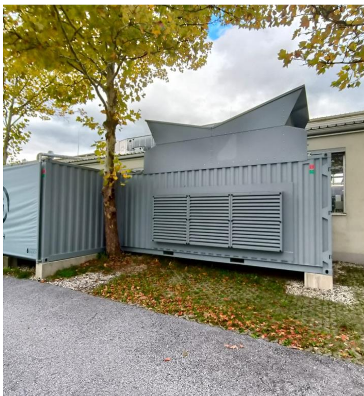
Abbildung 7: Wärmepumpe-Einheit mit Puffer-Containern im Hintergrund
