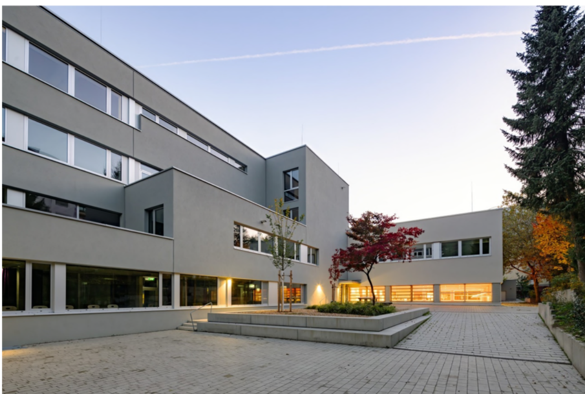
Hof Nordseite - seit 2024
