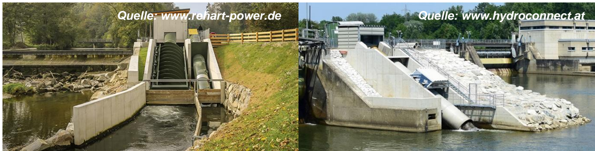
Abbildung 72: Schneckensysteme - Fischaufstiegsschnecke parallel zu Wasserkraftschnecke (links) und Fischaufstiegsschnecke in Wasserkraftschnecke integriert (rechts)
