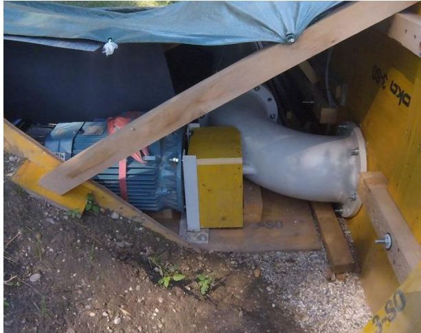
Abbildung 12: Pumpe und Saugkorb
