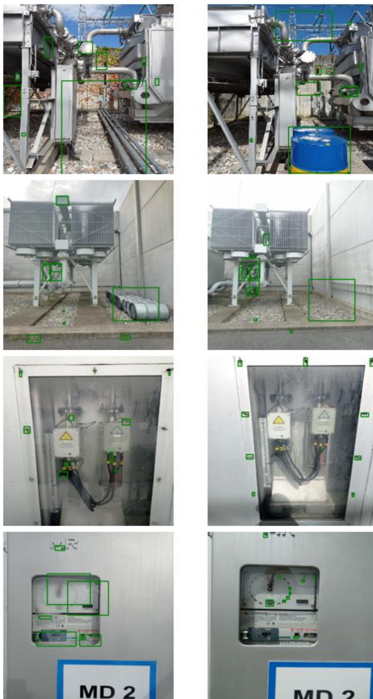
Abbildung 49: Beispiele für automatisch erkannte Veränderungen im Datensatz für Leistungstransformatoren. Wie im Text beschrieben, zeigen diese Beispiele ein passendes Paar fast identischer Leistungstransformatoren (ganz oben), einen symmetrischen Teil desselben Transformators (zweites von oben), und zwei Stellen, die zu zwei verschiedenen Zeiten überprüft wurden (unten).
