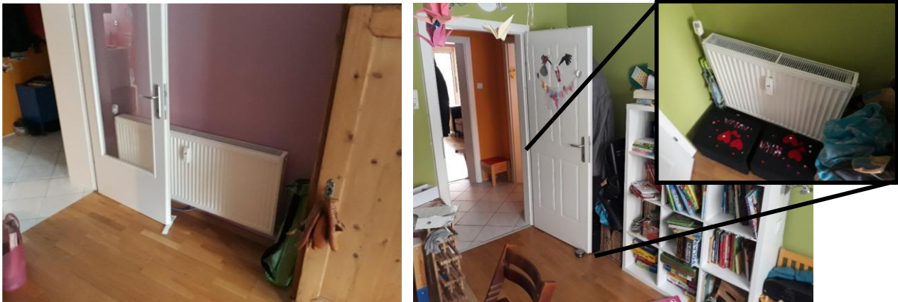
Abbildung 43: Positionierung der betriebenen Radiatoren in Wohnung, A1 (Wohnzimmer (links) und Kinderzimmer (rechts)). Die restlichen drei Heizkörper in der gegenständlichen Wohnung (Schlafzimmer, Badezimmer, Küche) wurden nicht aktiviert
