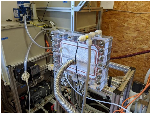
Abbildung 23: Permeatkanalseite der VMD-Membrantestzelle während der Versuche, mittels Unterdrucks wird über den Metallschlauch im Vordergrund das abtrennte Ammoniak(gas) abgezogen
